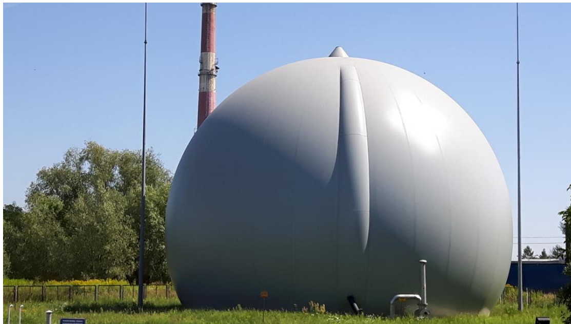
Fotografia 7. Zbiornik biogazu, MPWiK Sp. z o.o. w mieście Rzeszowie 47
