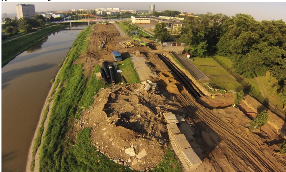
Fotografia 5. Modernizacja sieci ciepłowniczej w mieście Rzeszowie 39
