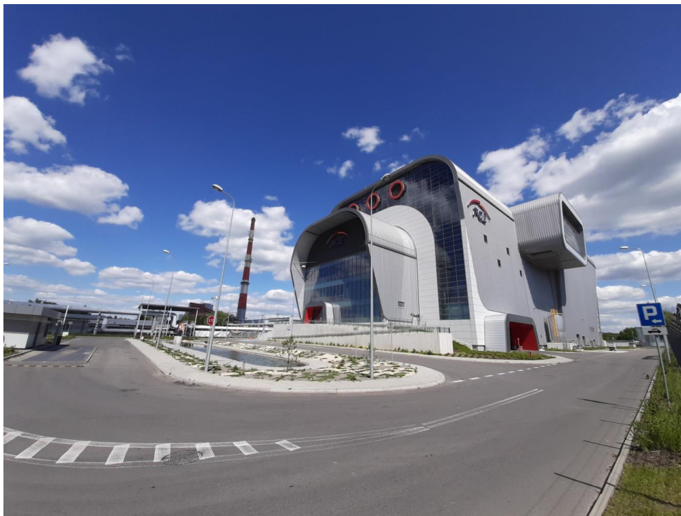
Fotografia 11. Instalacja Termicznego Przetwarzania z Odzyskiem Energii w mieście Rzeszowie (ITPOE) 103
